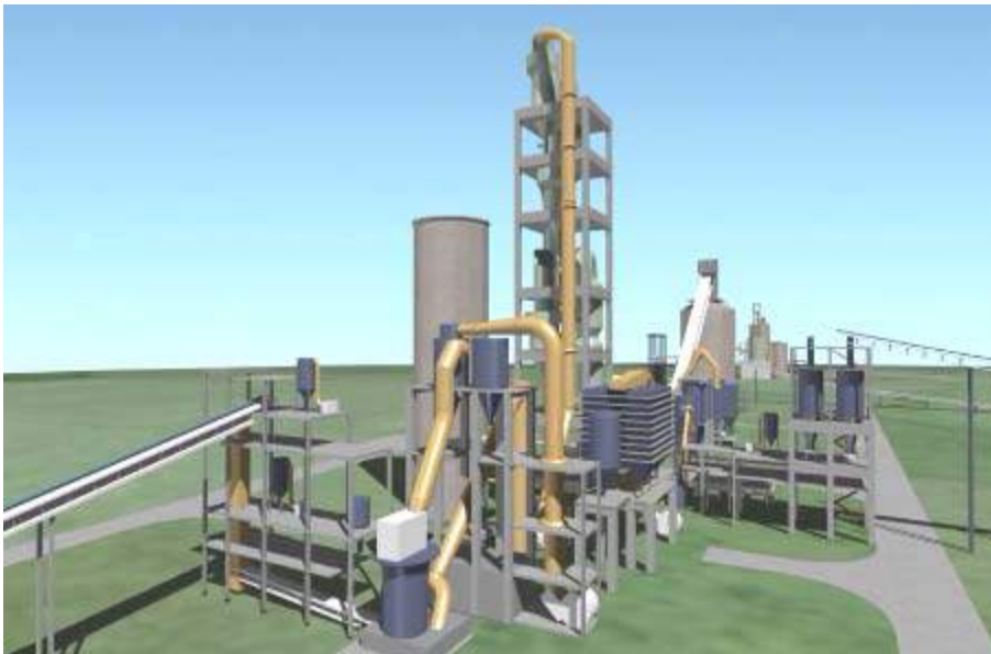
Figura 2-4 Molino de crudo, silo de crudo y filtro principal
