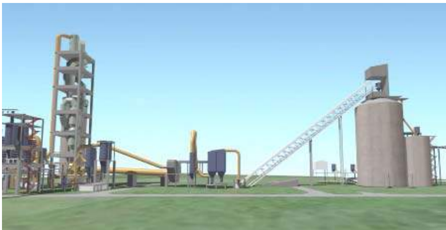
Figura 2-6 Molino, silos y planta de embolsado y despacho de cemento
